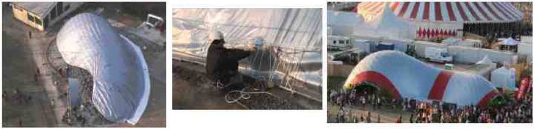
〈그림. Gridshell 뼈대 구조 및 PVC 코팅 멤브레인 설치모습〉
